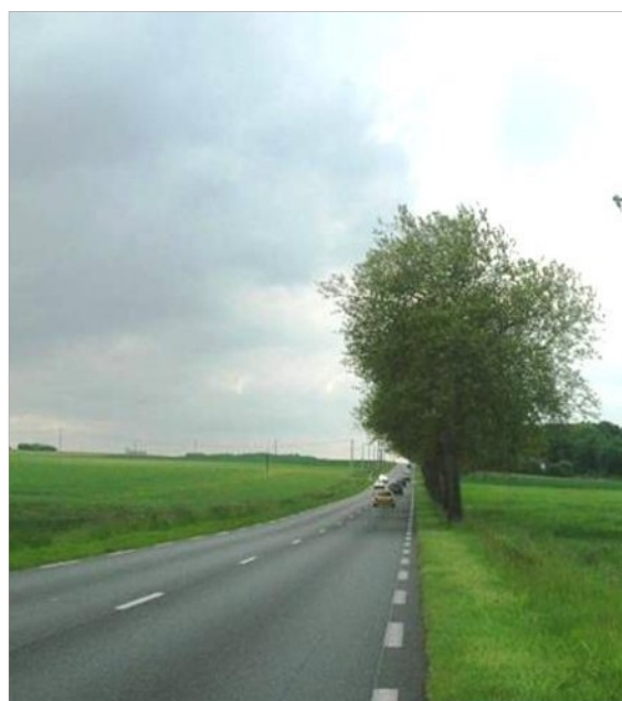
RD 910 : alignement unilatéral. Héritage d'un alignement bilatéral dont un côté a été abattu afin d'élargir et décaler la chaussée.
