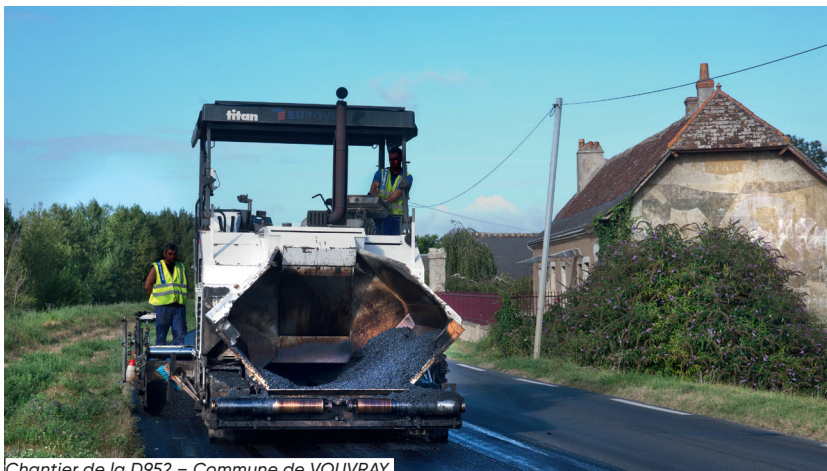
Chantier de la D952 – Commune de VOUVRAY
