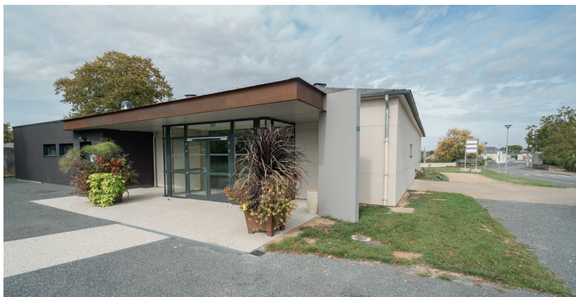
Rénovation d'une salle polyvalente – Commune de TAUXIGNY – Maître d'œuvre : Pascal BARANGER
