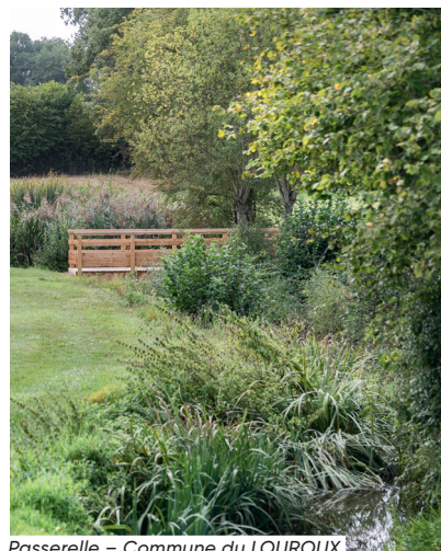
Passerelle – Commune du LOUROUX
