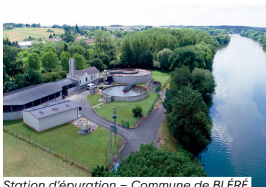
Station d'épuration – Commune de BLÉRÉ
