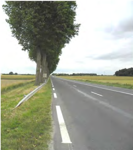
RD910 : alignement unilatéral. Héritage d'un alignement bilatéral dont un côté a été abattu afin d'élargir la chaussée à 3 voies de circulation.
