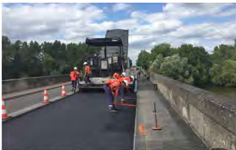
● Travaux sur le pont de Port-Boulet
