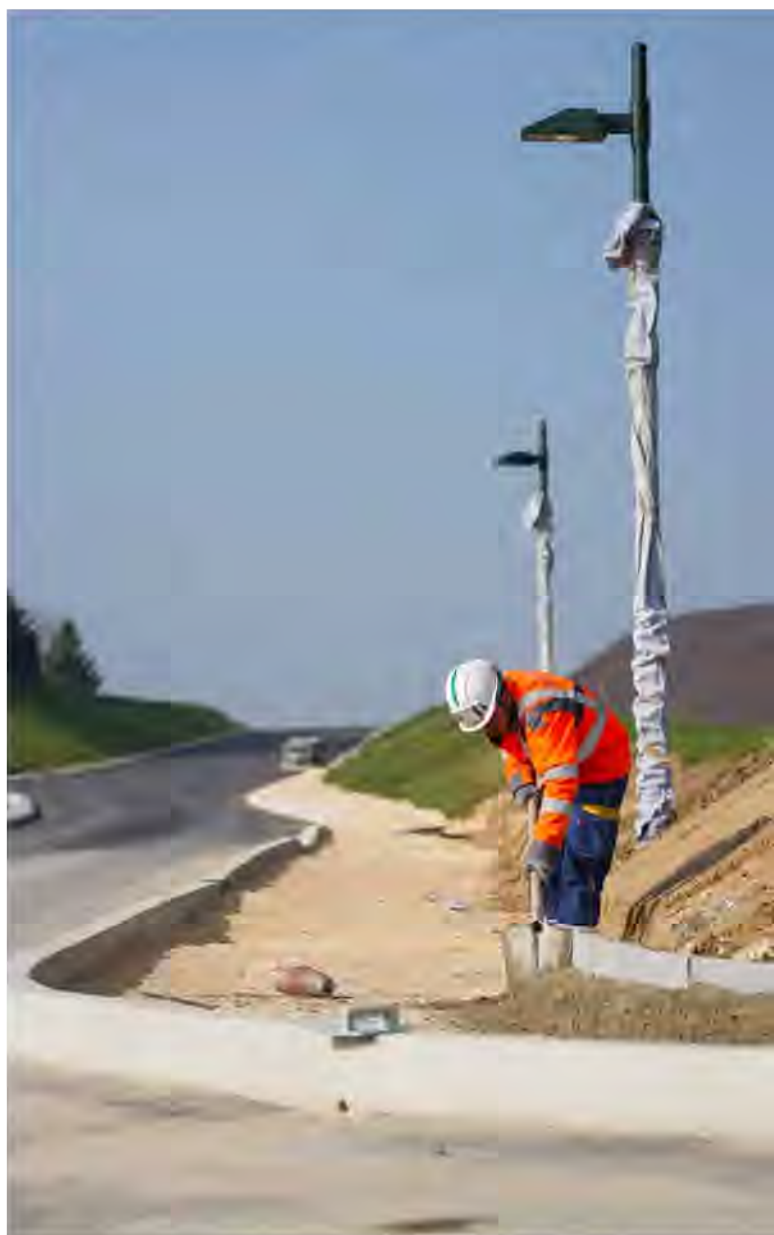
● Travaux de la déviation de Ciran sur la RD31
