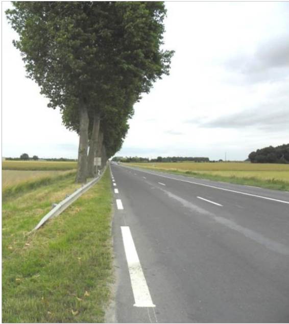
RD910 : alignement unilatéral. Héritage d'un alignement bilatéral dont un côté a été abattu afin d'élargir la chaussée à 3 voies de circulation.
